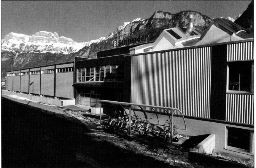
Das moderne Werk in Flums/SG wurde im Jahr 2004 gebaut und dient hauptsächlich als Produktionswerkstätte.
